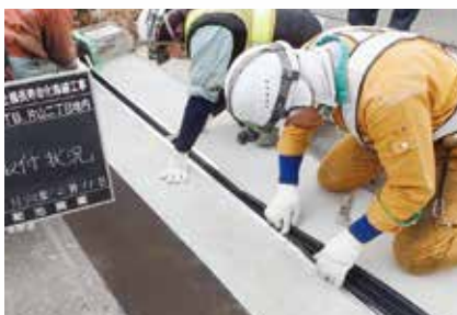
止水ゴム交換作業
