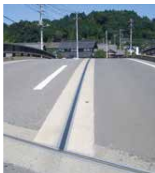
完成(縦目地での採用例)
