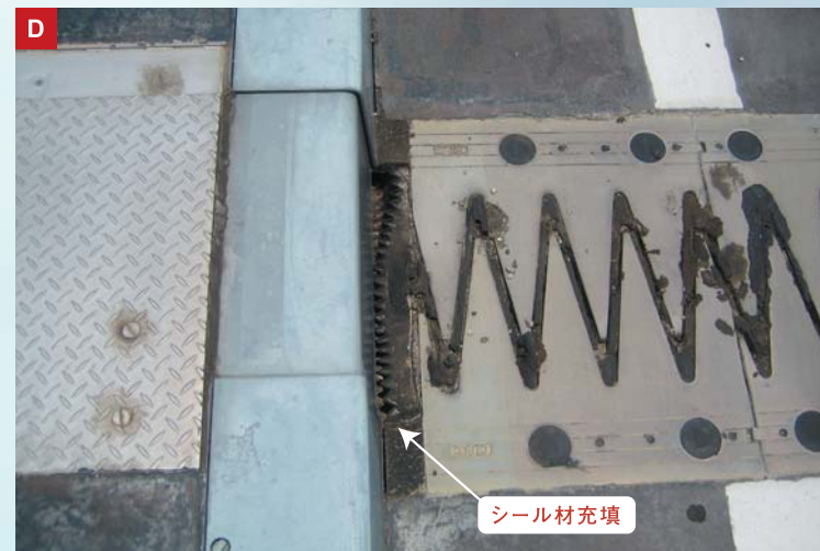
古宇利大橋の地覆部にある鋼製排水溝
