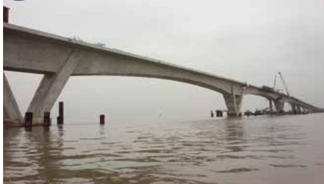
ラックフェン港橋(ベトナム国)
