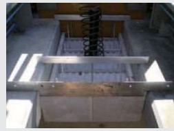
端横桁の施工
