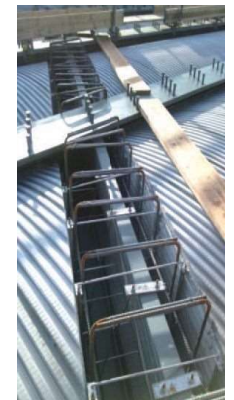
横桁の施工例
