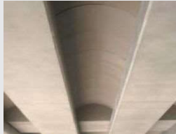
中間床版への適用事例
