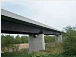
道東自動車道(平成11年)外側
