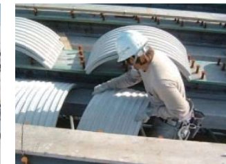
アーチフォームの敷設
