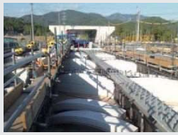
中間横桁の施工
