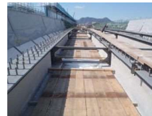
簡易足場の施工例
