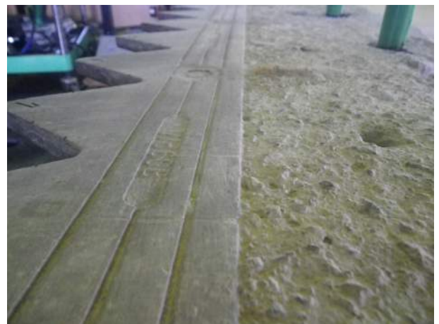
写真 5 伸縮装置表面の状態
