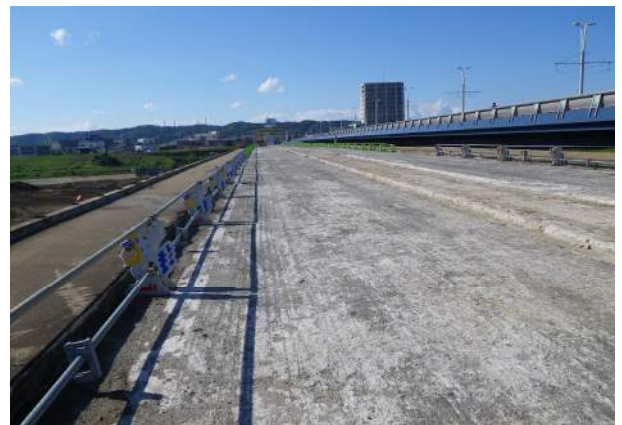
写真 1 床版撤去前の旧富山大橋
