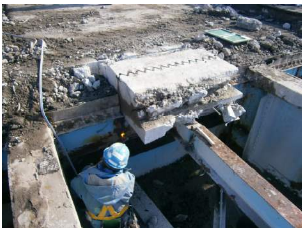
写真 2 伸縮装置採取状況
