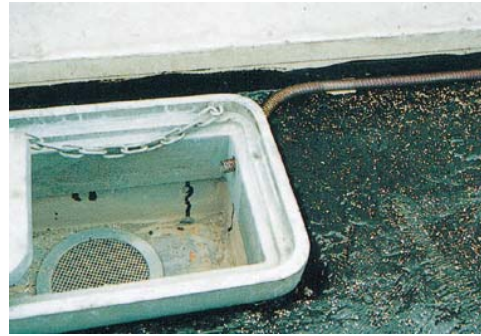
流末処理:ドレイナー端部を排水柵に接続
