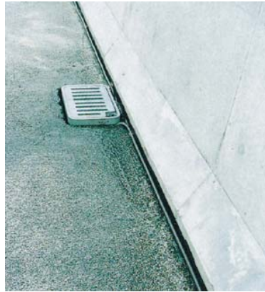
地覆隅角部に設置
