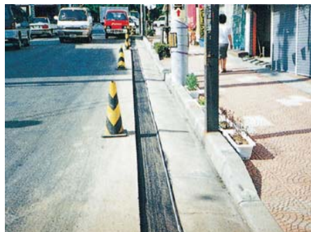
舗装基層上に設置
