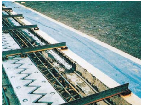
伸縮装置部に設置
