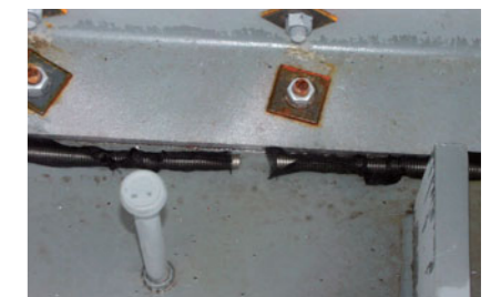
a) 導水装置端部の状況
