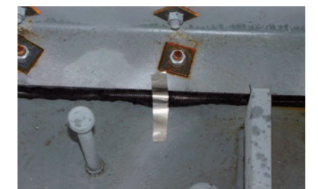
c) ステンレス製設置テープによる固定状況
