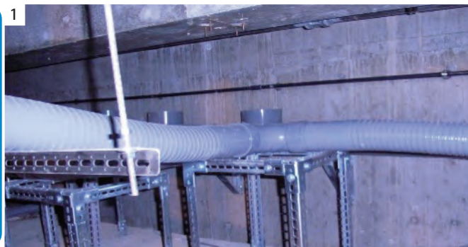
①大阪府 マンション 免震システム用フレキ [2007年施工] ②京都府 総合病院 免震システム用フレキ [2004年施工]
