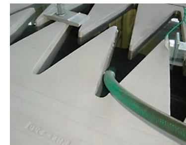
水張り試験状況
