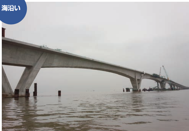
ラックフェン港橋(ベトナム国)
