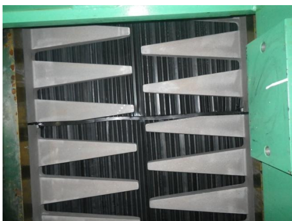
写真 20 水張り試験（裏面：タイプ 1）
