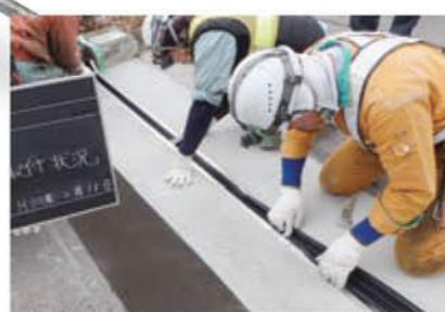
止水ゴム交換作業
