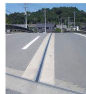
完成(縦目地での採用例)
