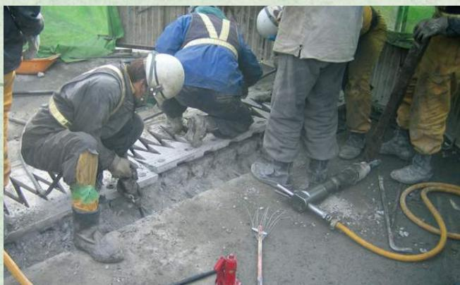
【写真-8】 アルミ製ジョイント(コンクリート解体作業)
