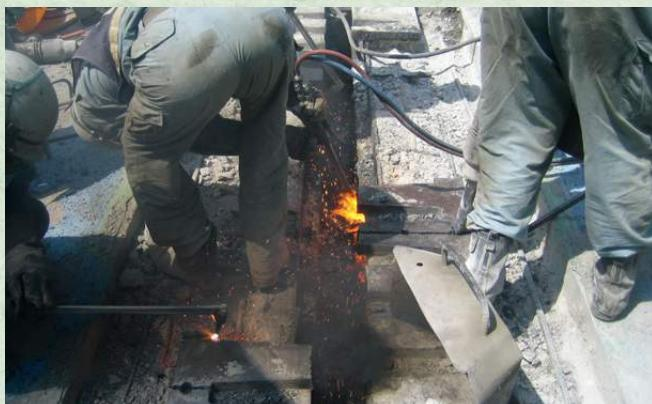
【写真-9】 鋼製フィンガージョイント(溶断作業)
